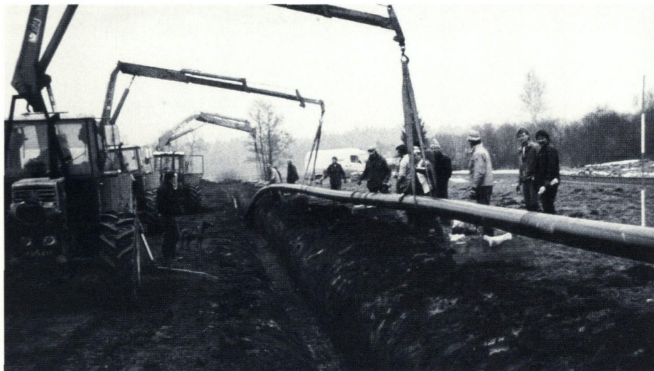
Absenkung der Rohrleitung im Bangserriet bei Ruggell
