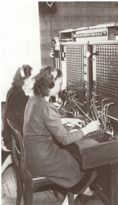
Die Vaduzer Telephonzentrale vor dem Umbau 1946 (links oben)
