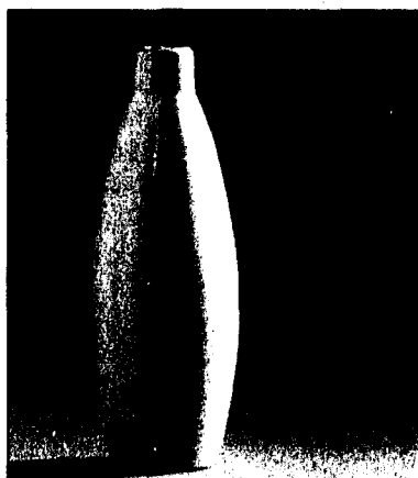
Tapeten mit unregelmässigen Falten:
