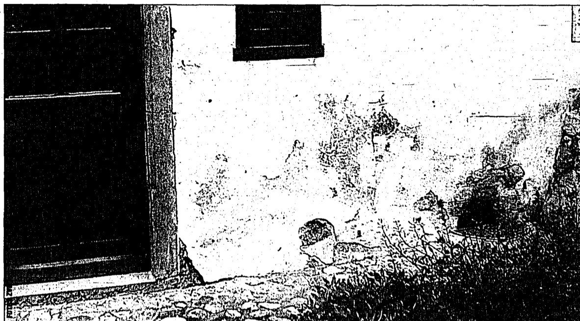
Im Mauerwerk aufgestiegenes Wasser verursacht sichtbaren Schaden. Remo Guntli ist der Ansprechpartner für dieses Problem.
