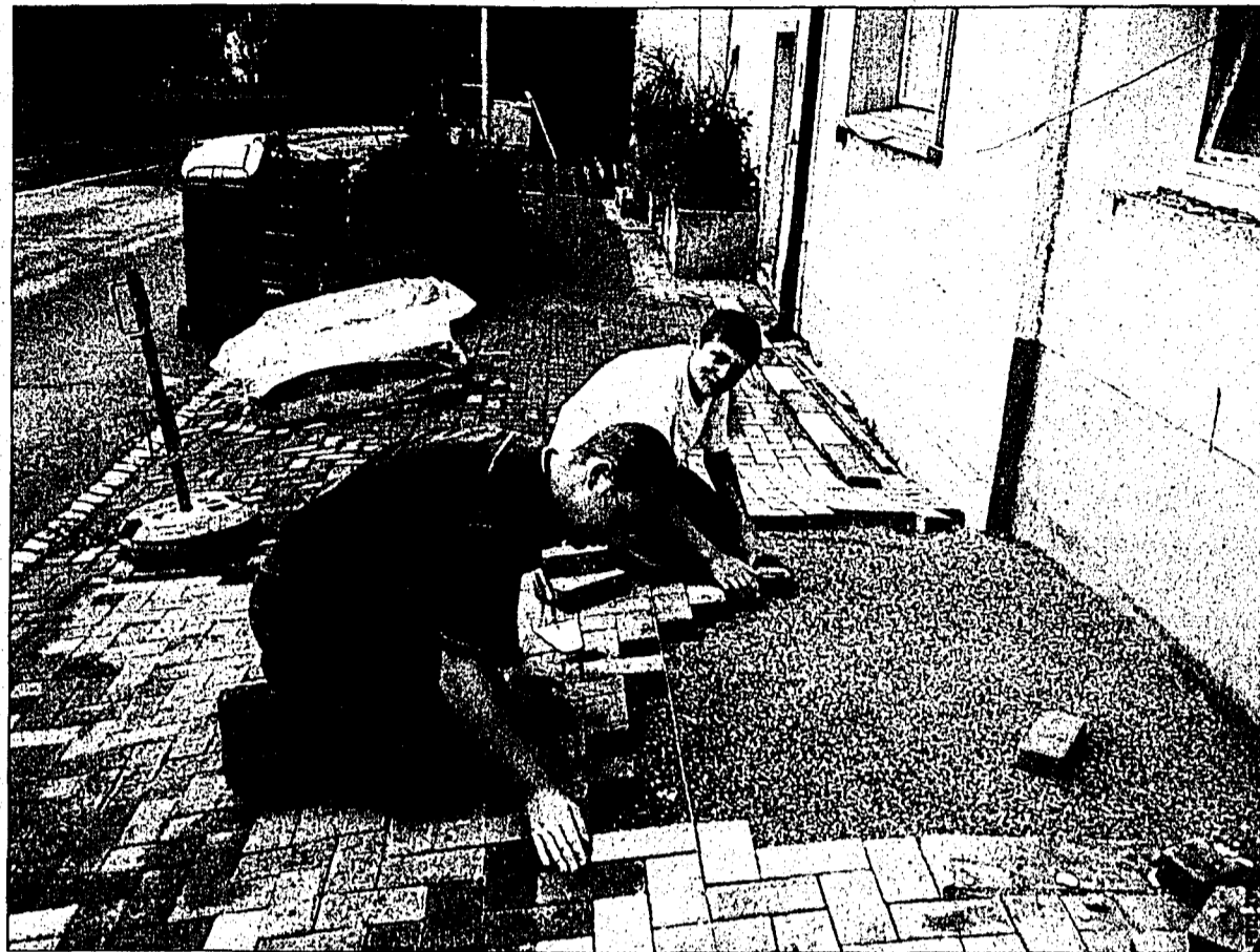
Die Kindertagesstätte Wartau wurde einer umfassenden Sanierung unterzogen.
