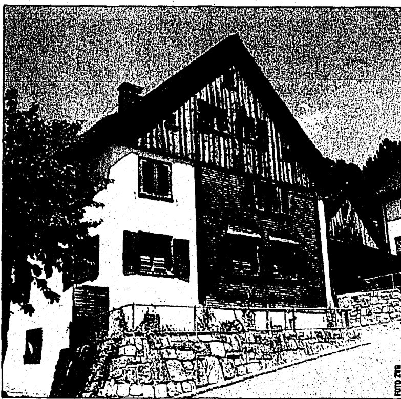
Am Samstag, den 28. August können alte Triesner Häuser besichtigt werden.
