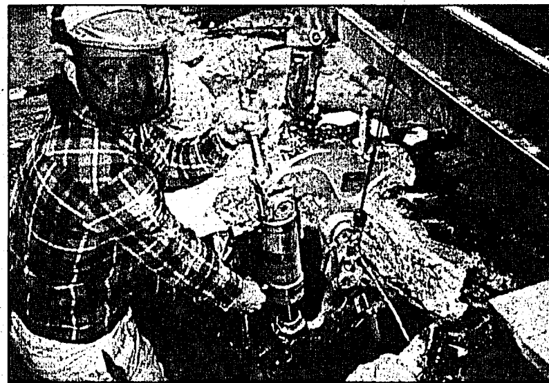
Beton beissen mit modernem Spezialgerät.
