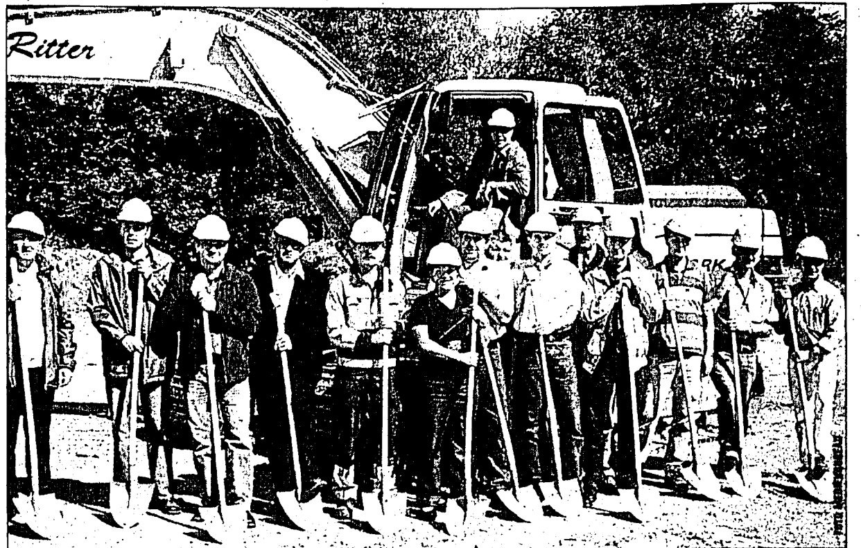
Spatenstich für das neue Mehrzweckgebäude in Mauren. Auf dem Bagger Gemeindevorsteher Freddy Kaiser, an den Schaufeln (von links) Theo Oehri, Stefan Schuler, Tescari Silvio, Ralph Beck, Ernst Meier, Vizevorsteherin Doris Wohlwend, Max Bühler, Emil Ritter, Jürgen Biedermann, Josef Mahlknecht, Georg Matt, Elmar Wohlwend, Gert Marxer, Ferdi Kaiser.
