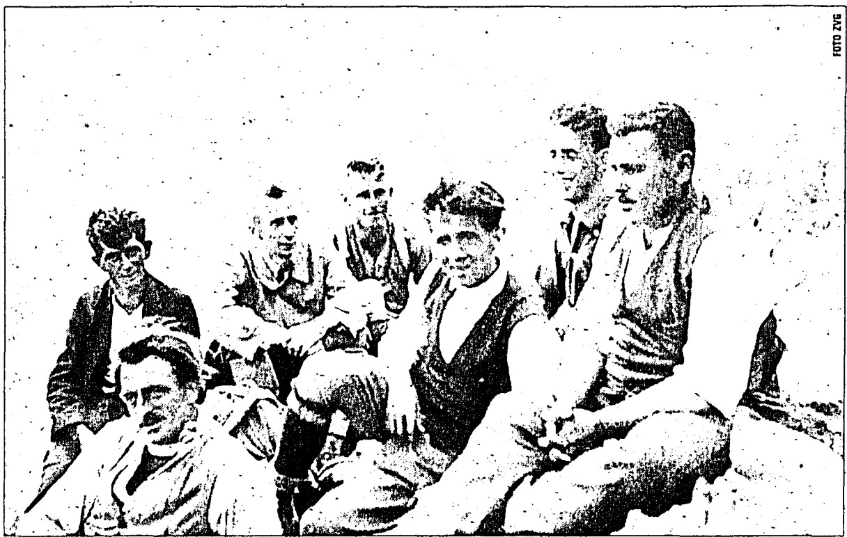
Kleine Verschnaufpause: Handwerker und Bauleute anno dazumal auf der höchsten Baustelle Liechtensteins.
