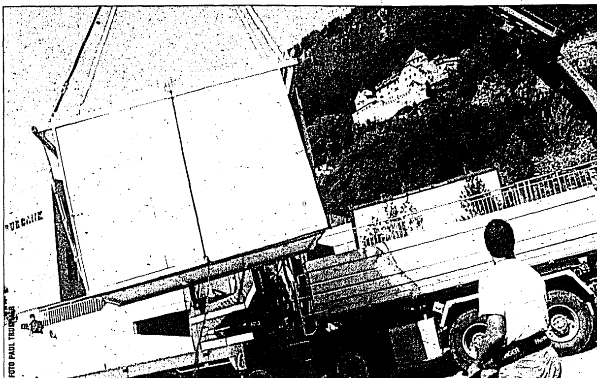
Aufbauarbeiten für das Kultur- und Kunstprojekt auf dem Dach der Marktplatzgarage in Vaduz.
