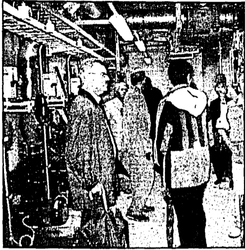
Zahlreiche Einwohnerinnen und Einwohner interessierten sich über die Fortschritte bei der Abwasserreinigungsanlage in Bendern.
