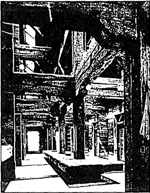
Das Bahnschwellenhaus des japanischen Architekten Shin Takasuga steht in einem «Architektur-Diskurs» an der Fachhochschule Liechtenstein.
