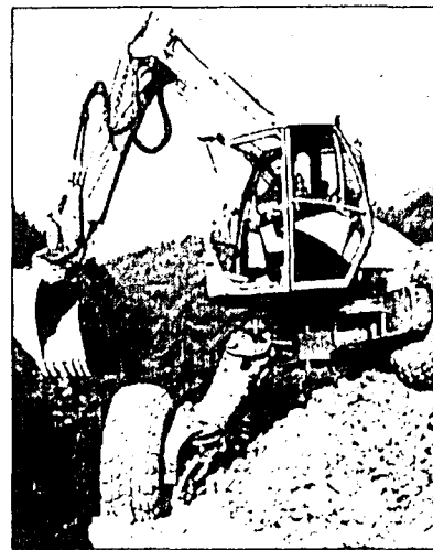
Der neue Schreit-Bagger der Kaiser AG macht vor allem im unwegsamen Gelände eine ausgezeichnete Figur.
