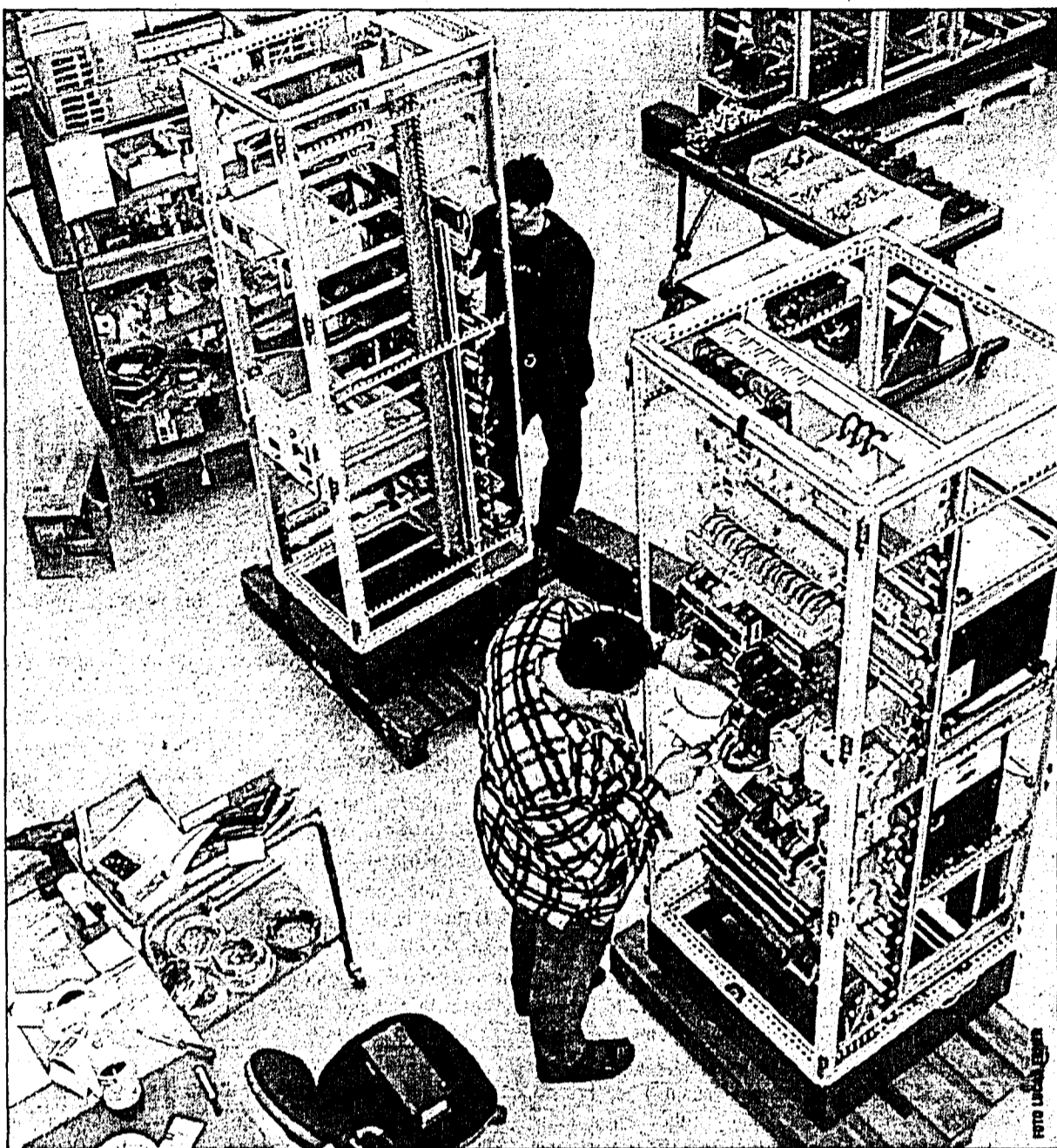
Blick in den Produktionsbereich der NeuElektrik AG in Schaan.
