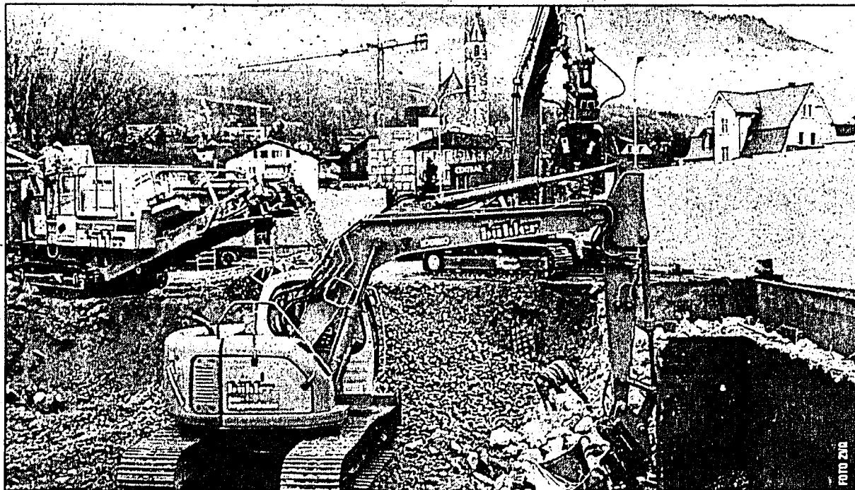
Mit Bagger und Abbruchzange wurde das Gebäude ehemaliger Buurabund in Schaan abgebrochen und das Besondere am Arbeitsvorgang war der umweltfreundliche Aspekt.
