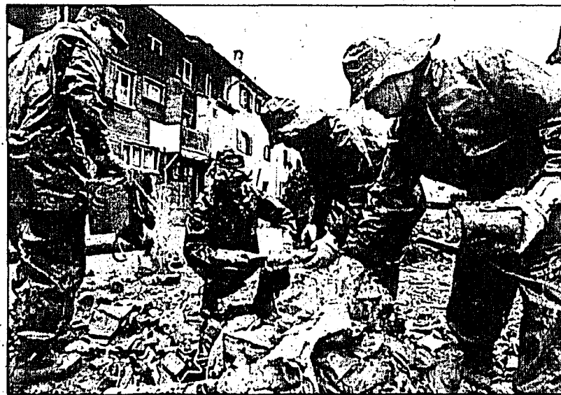
Die Aufräumarbeiten in Graubünden sind in vollem Gang.
