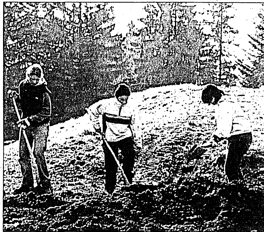
Beton schaufeln ist ganz schön anstrengend und braucht Muskelkraft.
