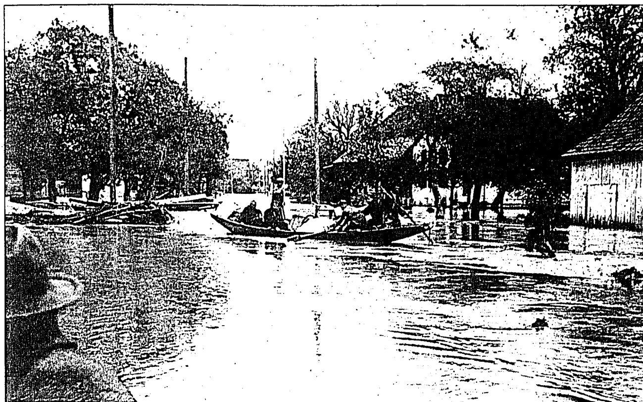
Am Tag nach der Katastrophe befanden sich in Ruggell immer noch über 300 Bewohner in ihren Häusern. Sie wurden mit Schiffen abgeholt und an trockenes Land gebracht. (Bild: Gemeinde Ruggell)
