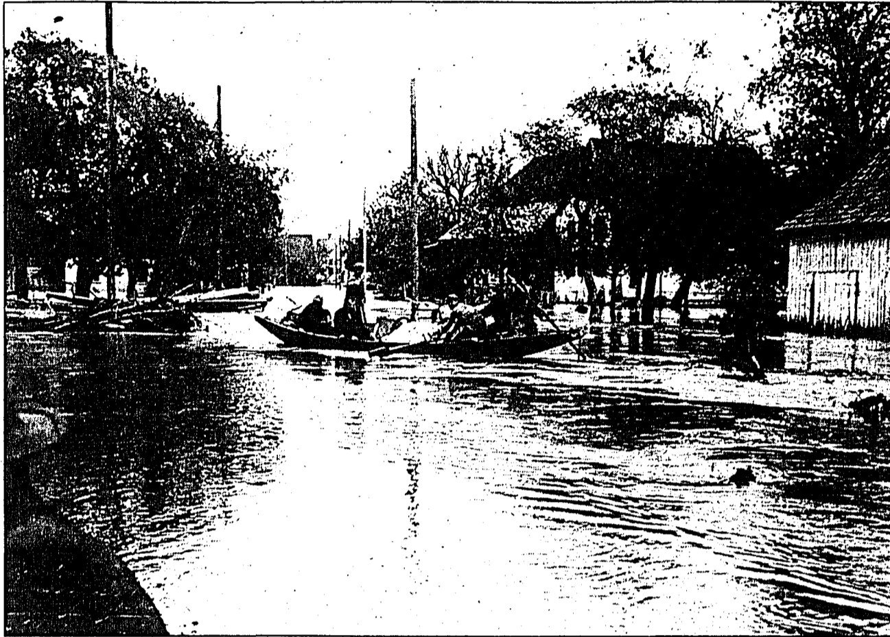
Am Tag nach der Katastrophe befanden sich in Ruggell immer noch über 300 Bewohner in ihren Häusern. Sie wurden mit Schiffen abgeholt und an trockenes Land gebracht. (Bild: Gemeinde Ruggell)
