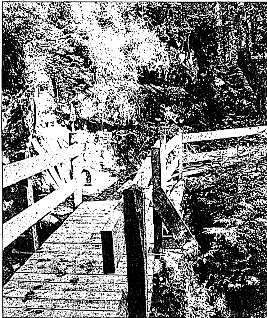
Die Vorbereitungsarbeiten laufen auf Hochtouren.
