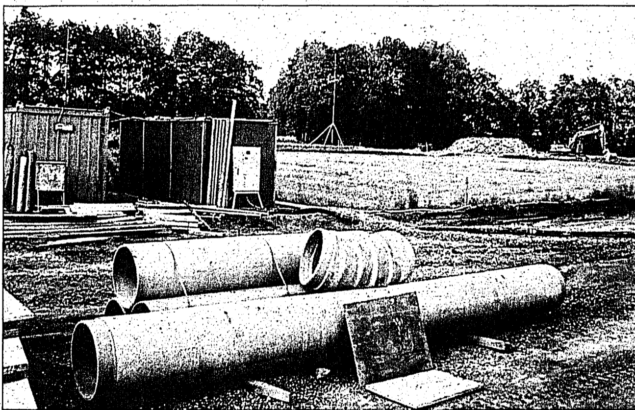
Die Erschliessungsarbeiten für die Bebauungsfelder der neuen Industrie- und Gewerbezone NORD in der Ruggeller Widau sind im vollen Gange. (Bild: Reto Öhri)
