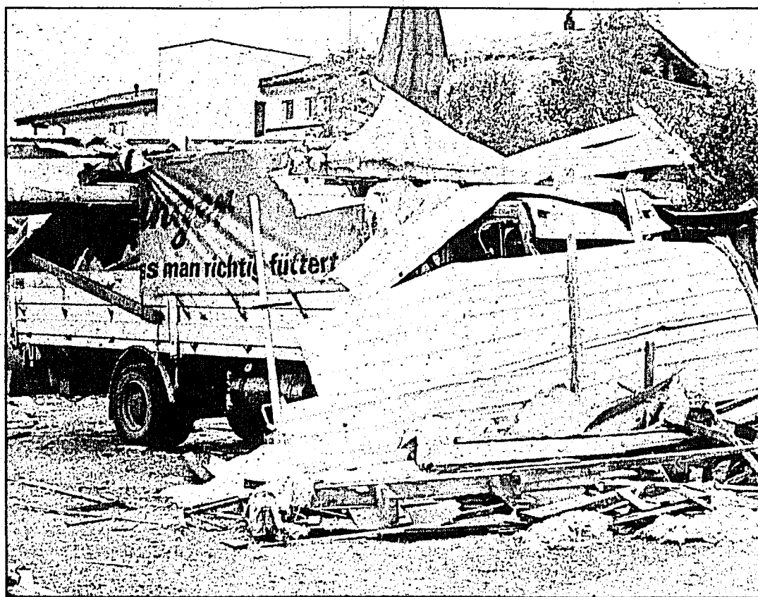
In Lenzburg riss der Sturm auch das Dach eines Fabrikgebäudes herunter.
