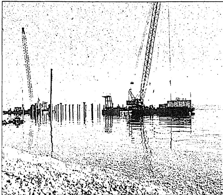
Bauarbeiten an der Expo.01 am 7. Oktober 1999 in Neuchâtel. Kurz zuvor hatte der Bundesrat beschlossen, der Expo.01 einen Zusatzkredit zu gewähren und sie auf 2002 zu verschieben. (Bild: Keystone)
