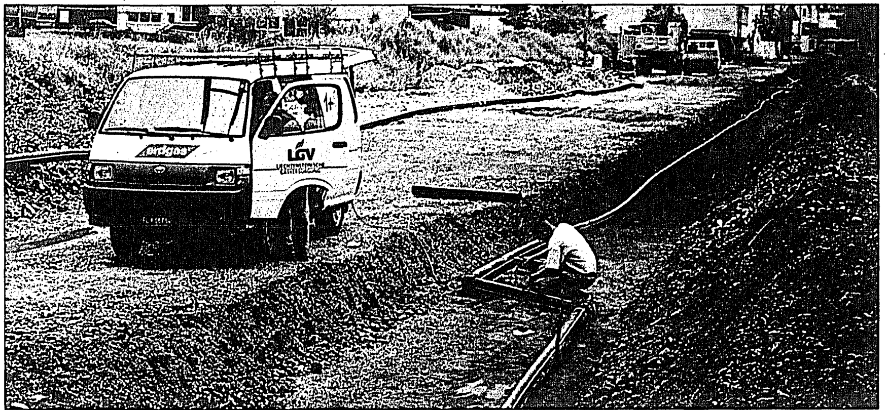
Die Liechtensteinische Gasversorgung (LGV) bleibt wie bisher Versorger für den Grossteil der heutigen Gasverbraucher.
