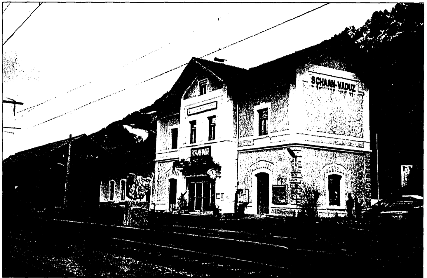
Das Schaaner Bahnhofgebäude wurde als Bestandteil der Eisenbahnverbindung Feldkirch - Buchs in den Jahren 1871/72 durch die Kaiserlich-Königlich privilegierte Vorarlberger Bahn (VB) errichtet. (Bilder: adi)
