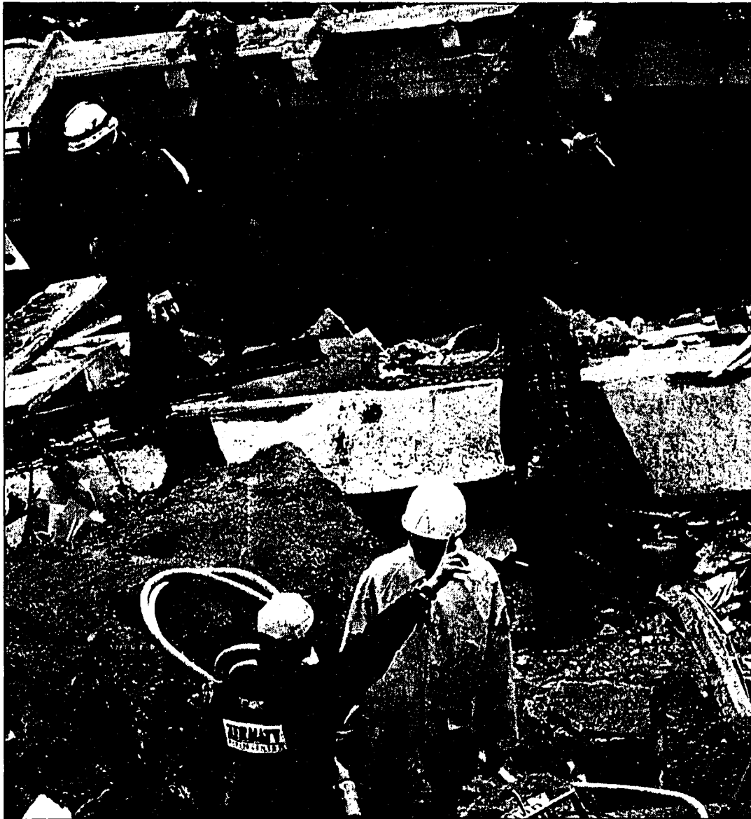
Die Aufräumarbeiten im stark beschädigten Walliser Grenzort Gondo gingen auch gestern ununterbrochen weiter. Die Hoffnung, noch Überlebende unter den Trümmern zu finden, schwand von Stunde zu Stunde.
