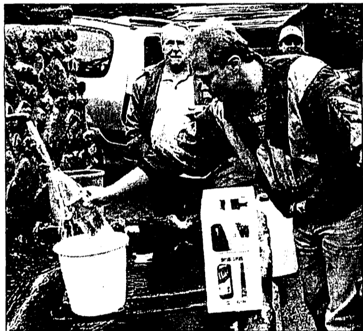
Das Wasserreservoir in Naters ist, als Folge der heftigen Regenfälle, zusammengebrochen. Die Bevölkerung muss das Trinkwasser von einem Brunnen holen oder bei einem Tankwagen, der durchs Dorf fährt, beziehen.
