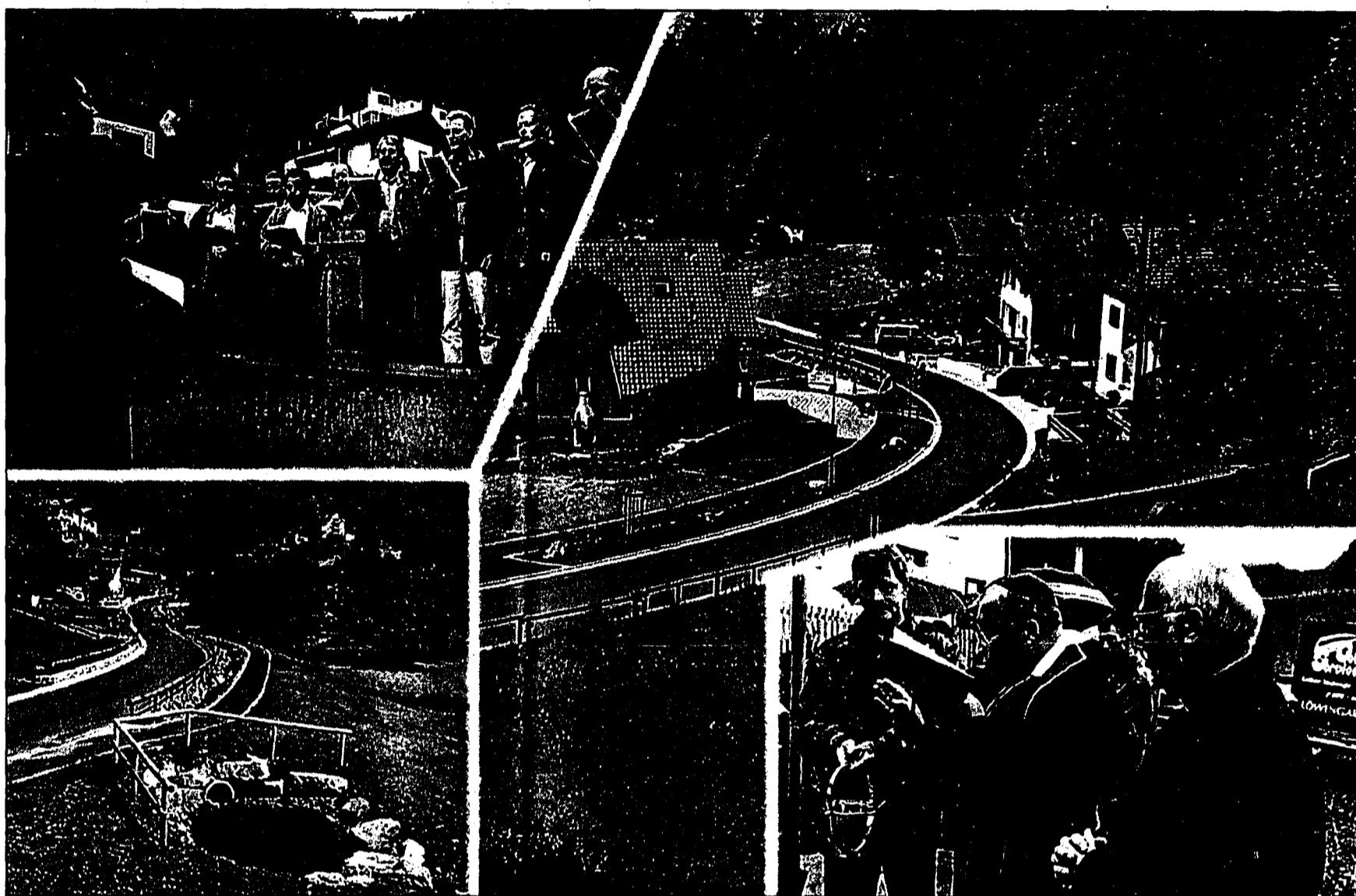
Blick auf den 1995 durch einen Rufeniedergang verschütteten Weiler Sütigerwis, die nunmehr fertiggestellte Strasse und den offenen Bach.
