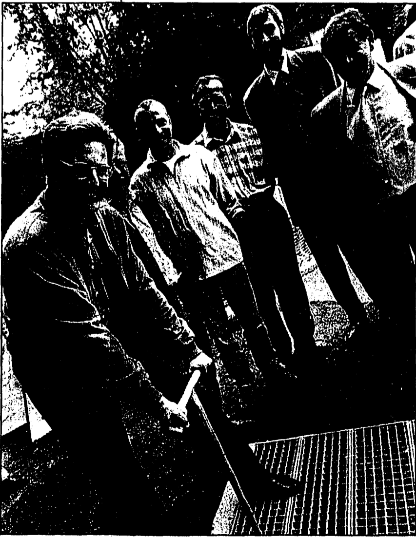
Vaduzer Bürgermeister Karlheinz Ospelt betätigt den Schieber, der das Abwasser in die Kläranlage Bendern umleitet. (Bild: Ingrid)
