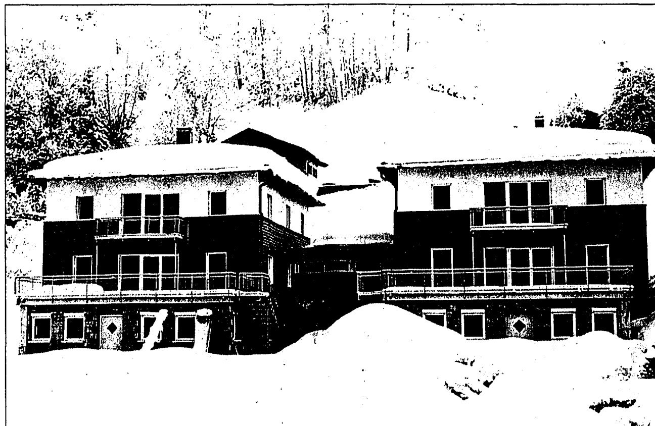
Verdichtete Bauweise in Form von Fertighäusern auf massiv aufgemauertem Kellergeschoss, diesen Traum vom Eigenheim haben sich zwei junge Familien in der Montafoner Gemeinde Silbierthal verwirklicht.
