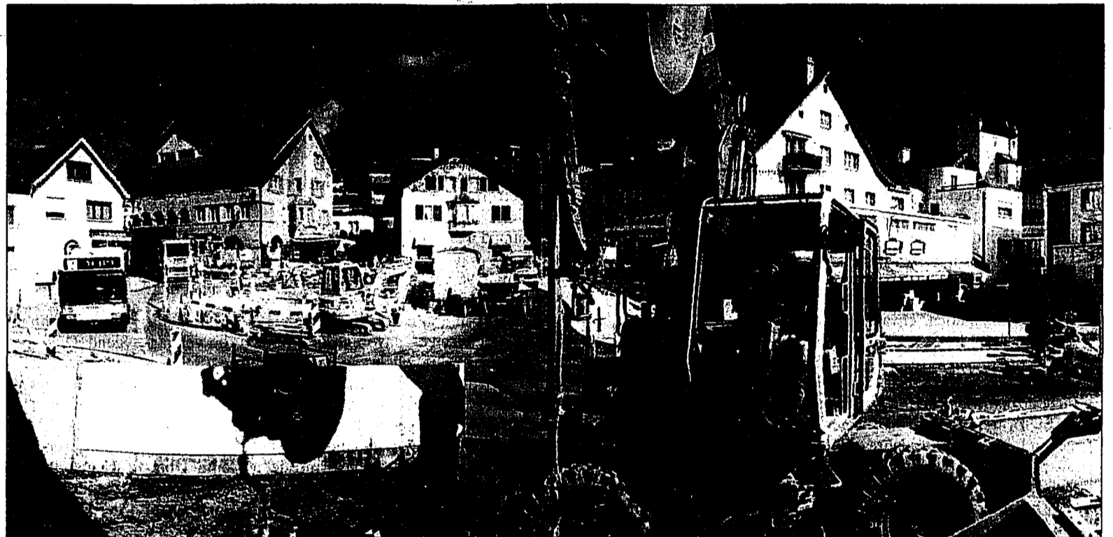
Das Strassenbauprogramm 1999, das die Regierung gestern zuhänden des Landtags verabschiedet hat, sieht Investitionen von 7 Mio. Franken vor. Schwerpunkte der Vorlage bilden neben diversen Strassenkorrekturen in Triesenberg, Schaan und Schellenberg die Realisierung von Verkehrskreiseln an der Aukreuzung in Vaduz und im Bereich der Einmündung der Industriestrasse Triesen in die Landstrasse. Bild: der «Adlerkreisel» in Vaduz neigt sich der Fertigstellung zu. Mehr zum neuen Strassenbauprogramm auf Seite 3
