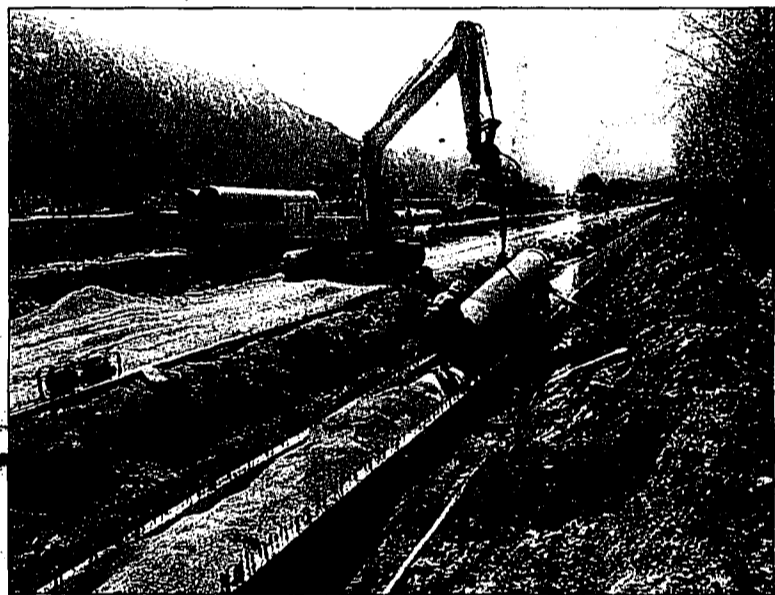
Die Bauarbeiten für den Abwasser-Hauptsammelkanal Vaduz – Bendern schreiten zügig voran. Links: die Rohrverlegung in die U-Betonprofile in Bendern. Rechts: in Schaan wurde teils mit dem sog. Micro-Tunneling gearbeitet.
