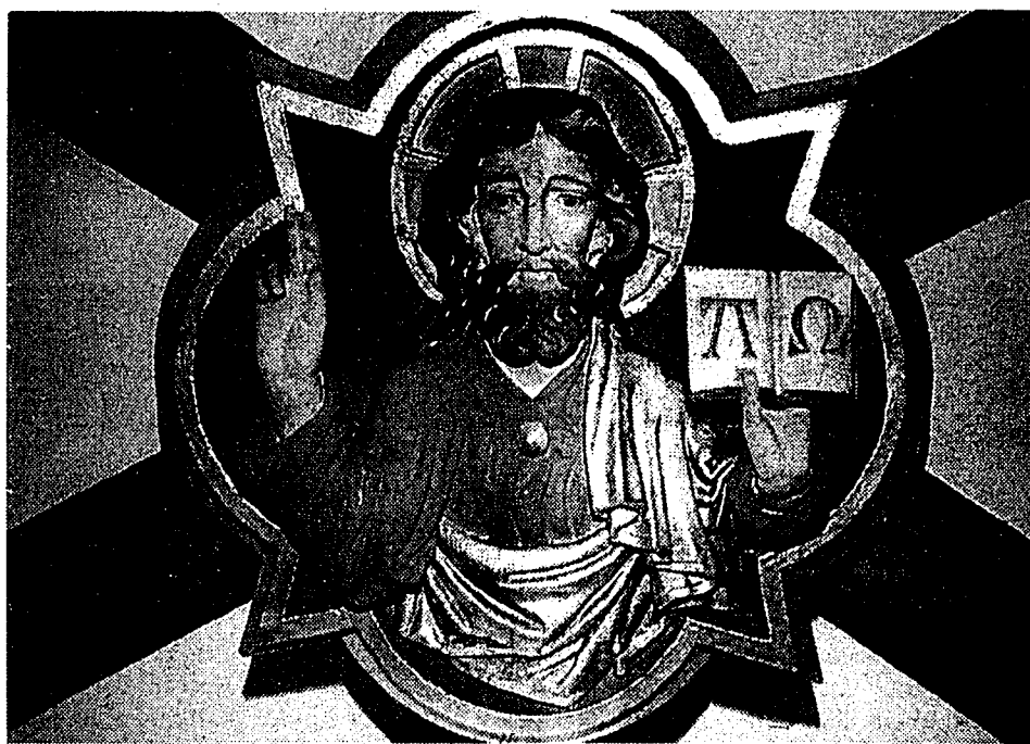
Segnender Christus: Schlussstein im Deckengewölbe der Pfarrkirche Vaduz (1873).
