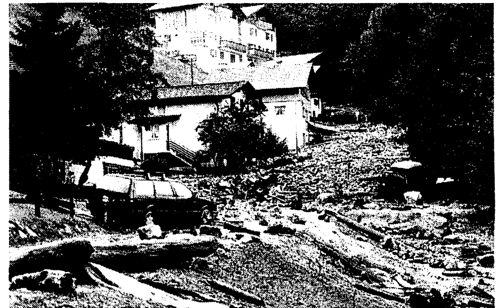
Für die Behebung der Unweterschäden vom 31. Juli beantragt die Regierung vorläufig einen Teilkredit von 3 Mio. Franken. Besonders arg betroffen wurde der Weiler Sütigerwies in Triesenberg (Bild).
