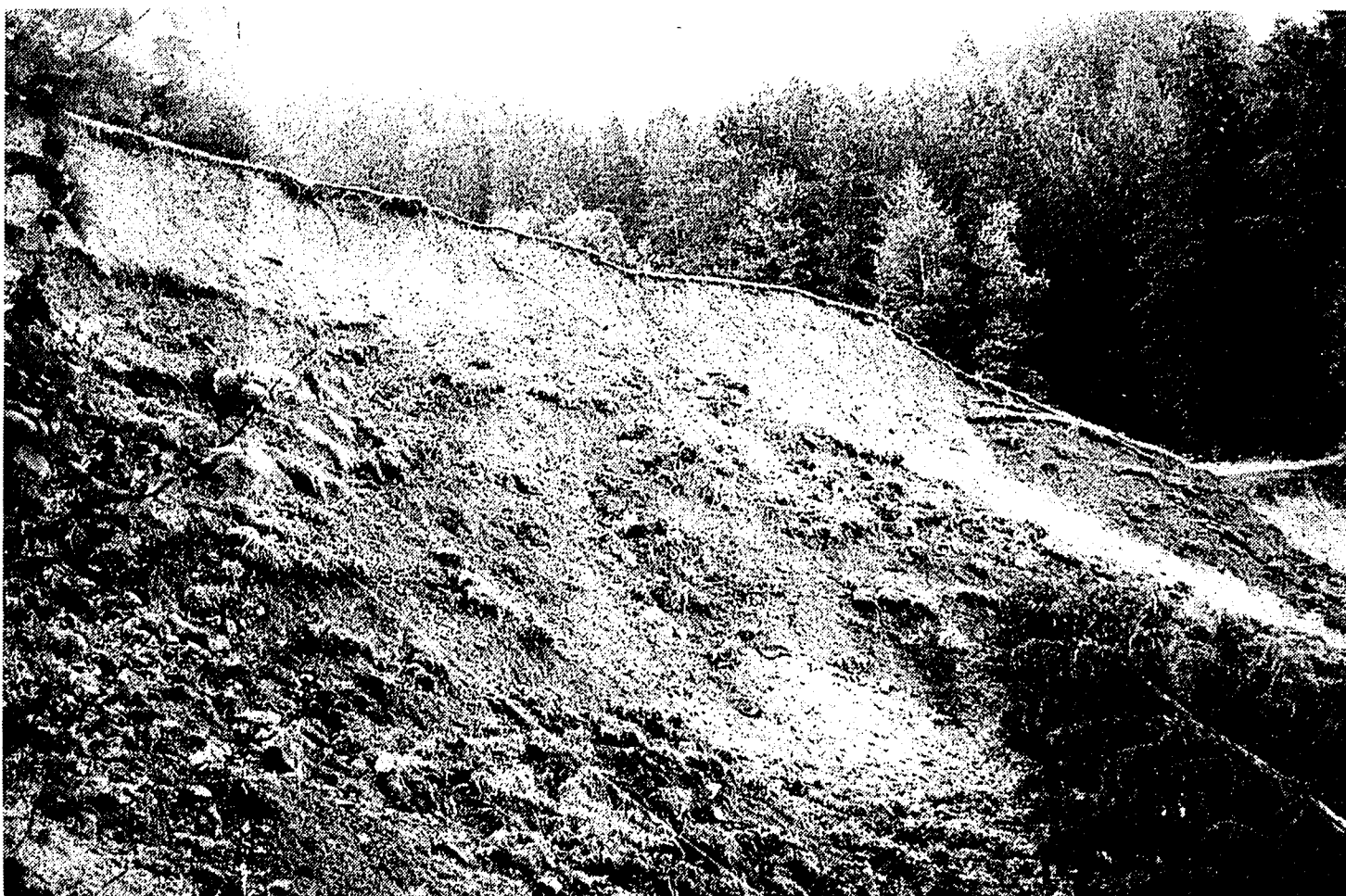
Der Rutschhang in Triesenberg ist wieder in Bewegung geraten. Als Sicherheitsmassnahme verfügten die Gemeindebehörden von Triesenberg die Evakuierung von weiteren Häusern. Für weitere Gewitter ist mit der Instandstellung der Kanalisation sowie mit der Bereitstellung von Sandsäcken zur Ableitung des Oberflächenwassers vorgesorgt worden.
