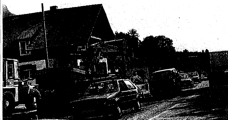
Totales Chaos herrschte am gestrigen Nachmittag auf der Hauptstrasse vor dem Grenzübergang Schaanwald. Die ausreisewilligen Automobilisten mussten sich in einem Stau, der auf die Bauarbeiten auf der Hauptstrasse vor dem Grenzübergang zurückzuführen ist, bis zu 45 Minuten in Geduld üben. Nach Angaben des Bauamtes soll die Baustelle bis Ende dieser Woche jedoch wieder verschwinden. (Bild: vito)
