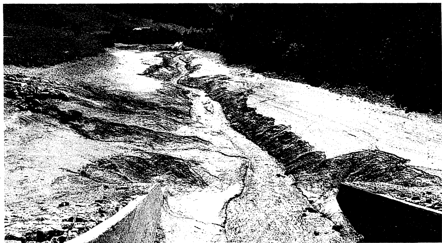
Die Liechtensteinischen Kraftwerke haben, wie bereits mehrfach angekündigt, nach den Sommerferien die Schleusen des Steger Stausees geöffnet. Bis zum 3. September wird das entleerte Gewässer bis zur ursprünglichen Sohle ausgebaggert; dabei werden rund 15 000 m 3 Schlamm (s. unter Bild) abtransportiert und für eine Aufschüttung im Gebiet des Maisässes Valüna verwendet. Mehr darüber im Innern dieser Ausgabe. (Bild: Klaus Schädler)
