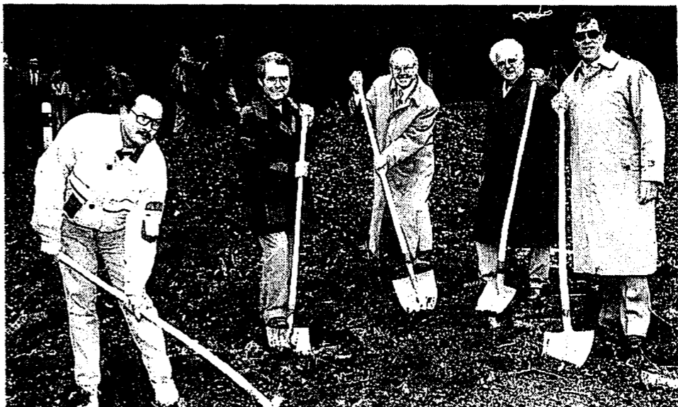
Spatenstich für das Gemeinschaftswerk Wasserreservoir/Kleinkraftwerk im Schlosswald: von rechts Walter Marxer, technischer Direktor der LKW, Ingenieur Norbert Vogt, Bürgermeister Arthur Konrad sowie die beiden Vertreter der Arbeitsgemeinschaft, Christoph und Günther Ospelt. (Bild: Roland Korner)
