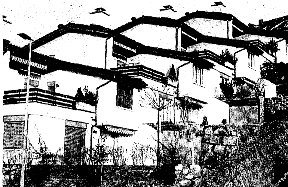
In den vergangenen drei Jahrzehnten häuften sich die auf liechtensteinischen Immobilien eingetragenen Hypotheken auf rund 3,5 Milliarden Franken an. (Archivbild)
