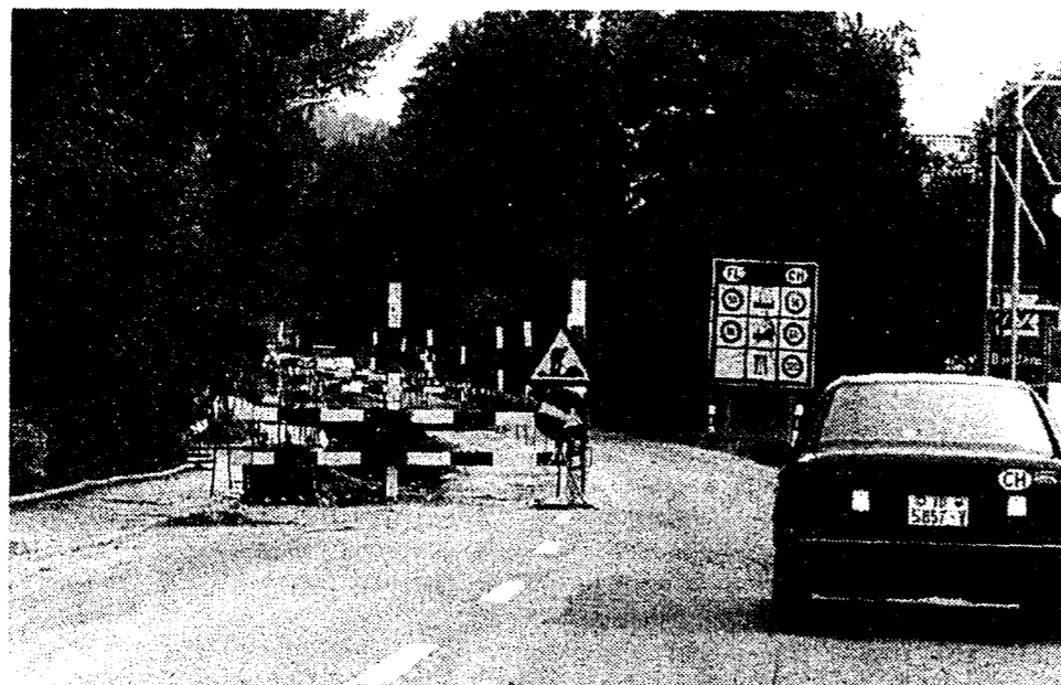
Verkehrsbehinderung in Schaanwald wegen dringenden Bauarbeiten an der Strasse. Im Grenzort aber sind auch Probleme des ständig zunehmenden Verkehrs über die Grenze Liechtenstein-Österreich zu bewältigen. Das Bauressort der Regierung befasst sich mit den Verkehrsproblemen, die zwar in Schaanwald beginnen, aber nicht auf den Grenzübergang beschränkt sind. (Bild: Beat Schurte)
