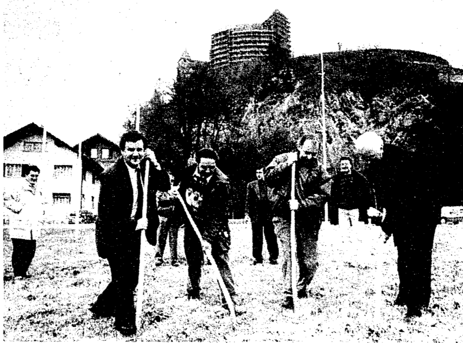
Mit dem Spatenstich wurde gestern der Bau des Alters- und Pflegeheimes «Unterm Schloss» in Balzers eingeleitet. Links im Bild Vorsteher Othmar Vogt, zweiter von rechts Architekt Hubert Ospelt. (Bild: R. Korner)
