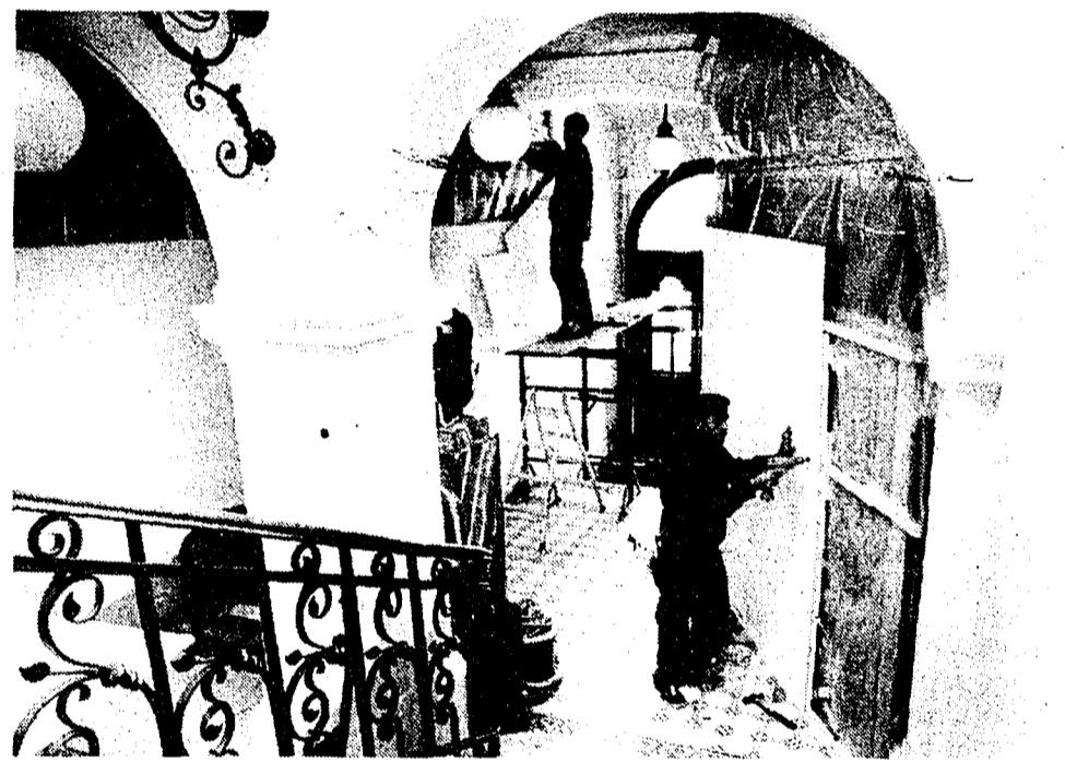
Im Regierungsgebäude sind wieder die Handwerker eingezogen. Im Rahmen der zweiten Sanierungsetappe werden heuer das Keller-, Erd- und erste Obergeschoss für 5,3 Millionen Franken um- und ausgebaut. (Bild: Roland Korner)
