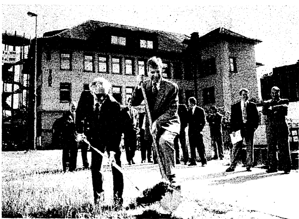
Am Dienstag wurde mit dem Spatenstich die Bauphase des Erweiterungsbaus der Liechtensteinischen Landesbank eingeleitet. Dabei legten Verwaltungsratspräsident Andreas Vogt (rechts) und Direktor Karlheinz Heeb selber Hand an. (Bild: R. Korner)
