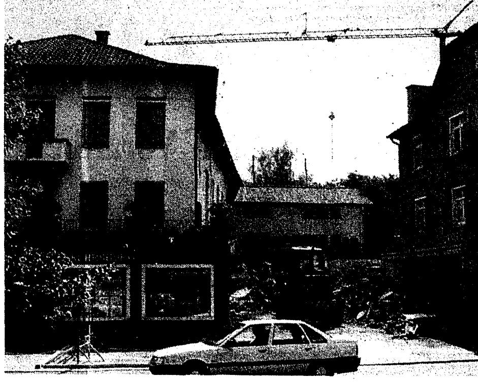
Mit diversen Abbrucharbeiten ist kürzlich die umfassende Renovation des alten Rathaussaales in Schaan eingeleitet worden. Man rechnet mit einer Bauzeit von rund zwei Jahren. (Bild: Beat Schurte)
