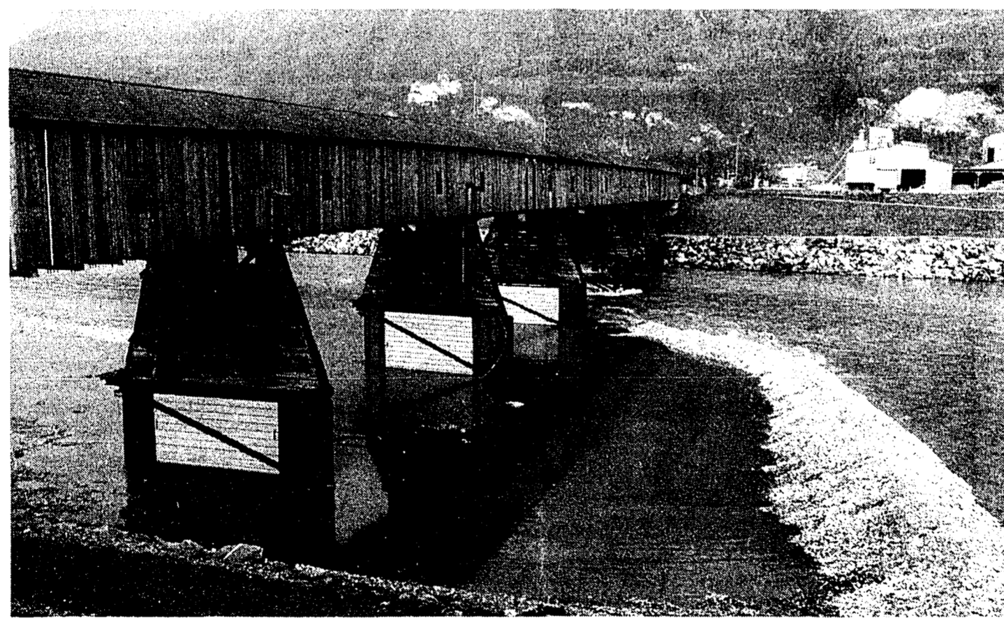
Die Regierung hat ein neues Rheingegesetz in die Vernehmlassung gegeben. Darin ist beabsichtigt, die Grundfläche entlang des Rheines in das gemeinsame Eigentum des Staates und der jeweiligen Gemeinde zu überführen. Rheinschutzmassnahmen sollen künftig gemeinsam von Staat und Gemeinden veranlasst werden. Unser Bild zeigt die Rheinbrücke Vaduz-Sevelen, wo derzeit Sanierungsarbeiten im Gange sind.
