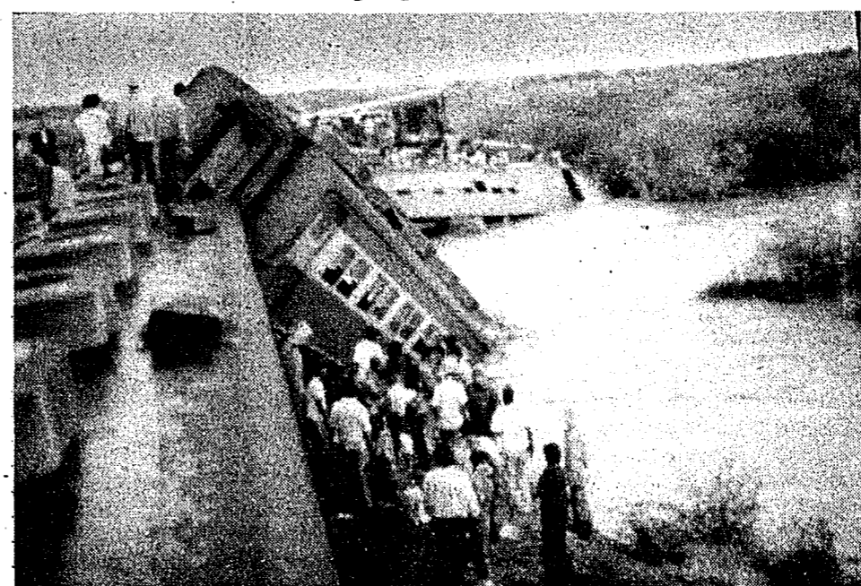
Der vollbesetzte Personenzug stürzte von einer vermutlich unterspülten Brücke in einen hochwasserführenden Fluss und riss zahlreiche Mexikaner in den Tod.
