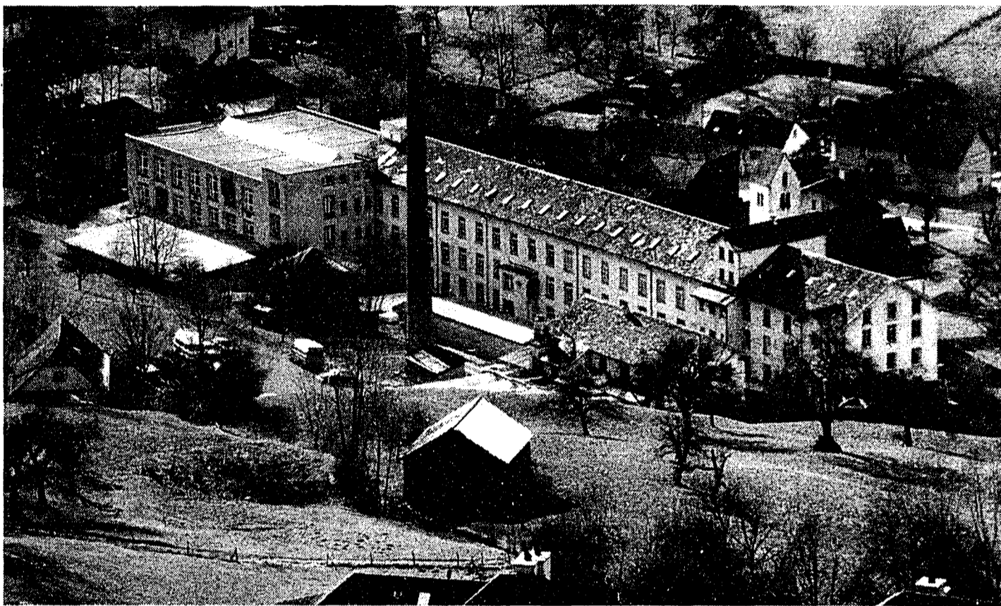
Durch den Kauf des Fabrikareals der Jenny Spoerry wurde ein 3165 Klafter grosses Areal in öffentlichen Besitz übergeführt. In Triesen überlegt man sich jetzt sinnvolle Nutzungsmöglichkeiten.
