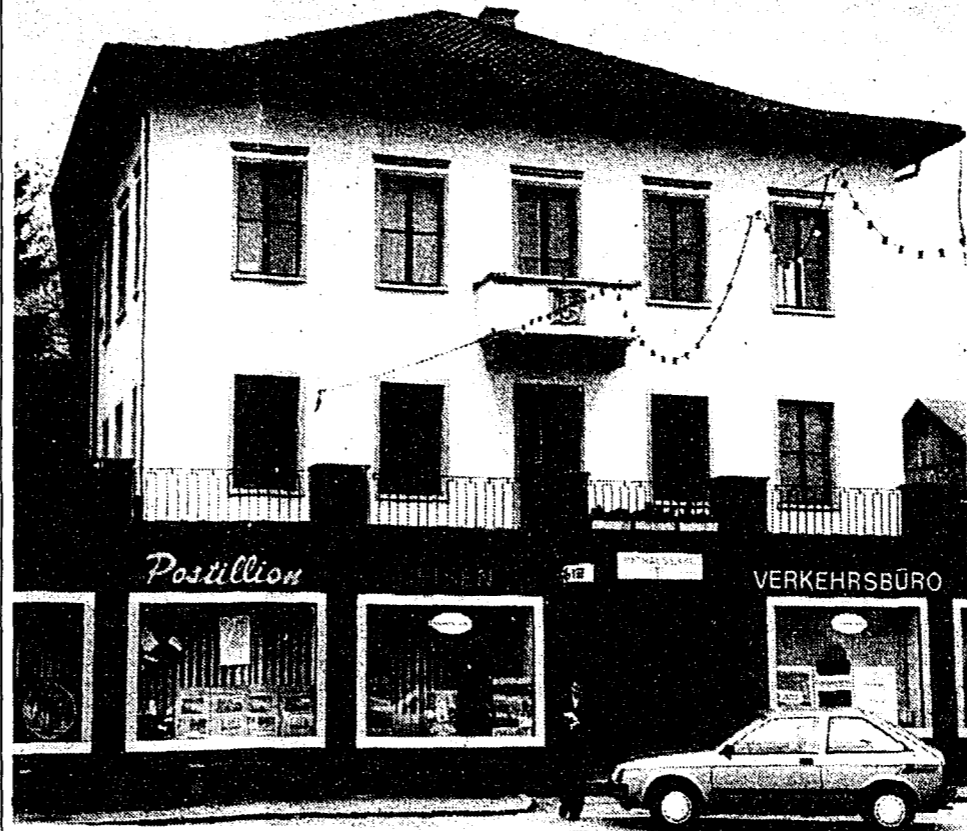
Mit geschätzten Kosten von 3,8 Millionen Franken soll der Saal im alten Schaaner Rathaus saniert werden. (Bild: Beat Schurte)
