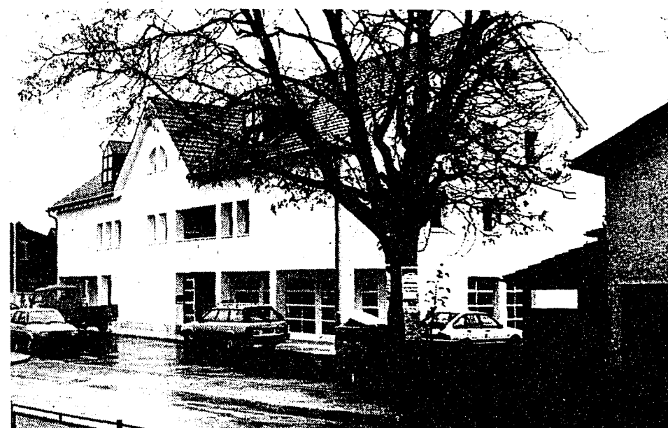
Nach rund zweijähriger Bauzeit wird das neue Postgebäude in Mauren am Samstag offiziell eröffnet und seiner Bestimmung übergeben. Nebst der geräumigen Post beherbergt das Gebäude auch eine Arztpraxis und Räume für Physiotherapie, Zollwohnungen und einen Zivilschutzraum. (Bild: Beat Schurte)
