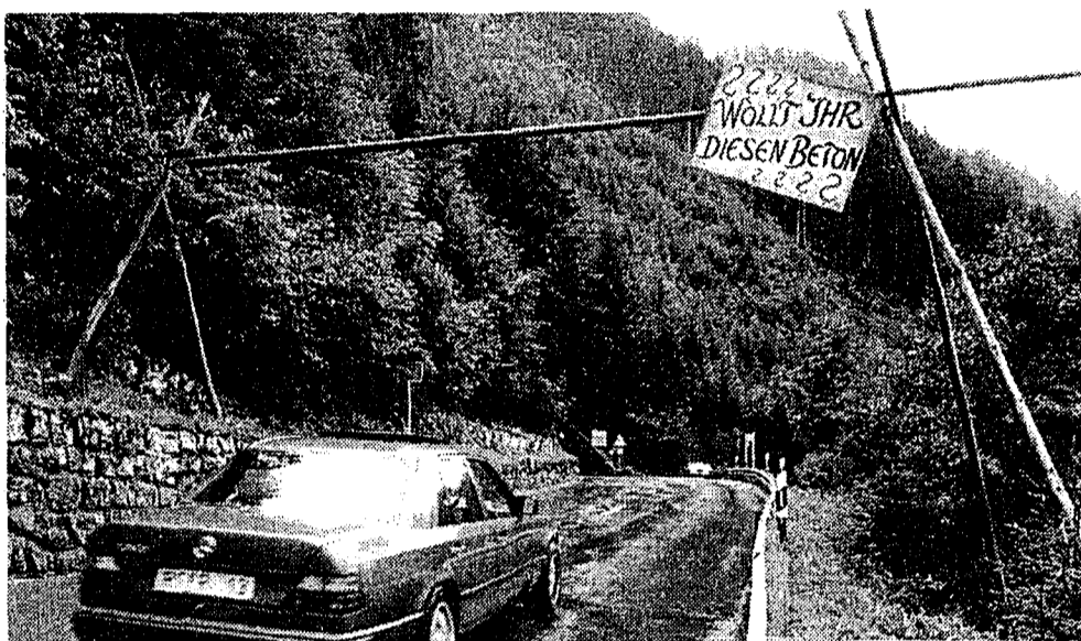
Die Latten zeigen das Ausmass der Betonierung für den Galeriebau zum Tunnelportal an. Die jetzige Strasse würde ca. 4 Meter talseits verbreitert, wobei rund 400 Klafter Bergwald zerstört würde. Die Initiativgruppe stellt sich gegen eine vom Landtag beschlossene Sanierung des alten Tunnels und schlägt den Bau einer neuen Röhre etwa 400 Meter unterhalb der heutigen Tunnelfahrt vor. (Bild: Brigitt Risch)
