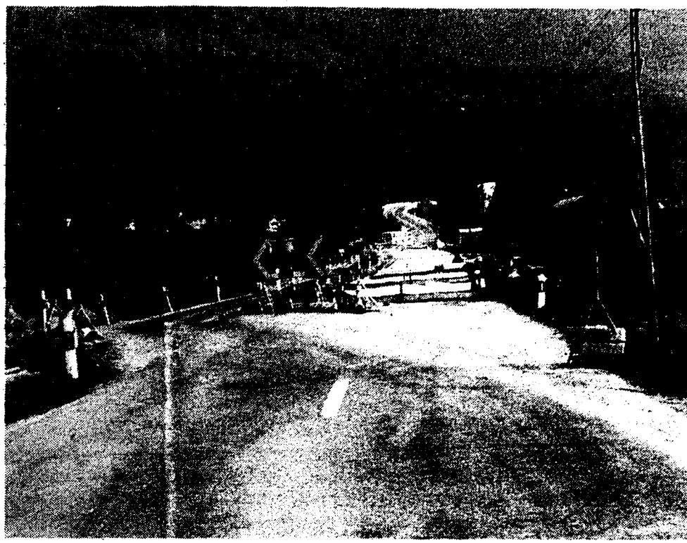
Der Neubau der Rietstrasse Mauren ist momentan voll im Gang. Das rund 660 Meter lange Teilstück wird nach einem speziellen Bauverfahren erstellt. Unser Bild: Blick in Richtung Schaanwald. (Aufnahme: A. Kieber)
